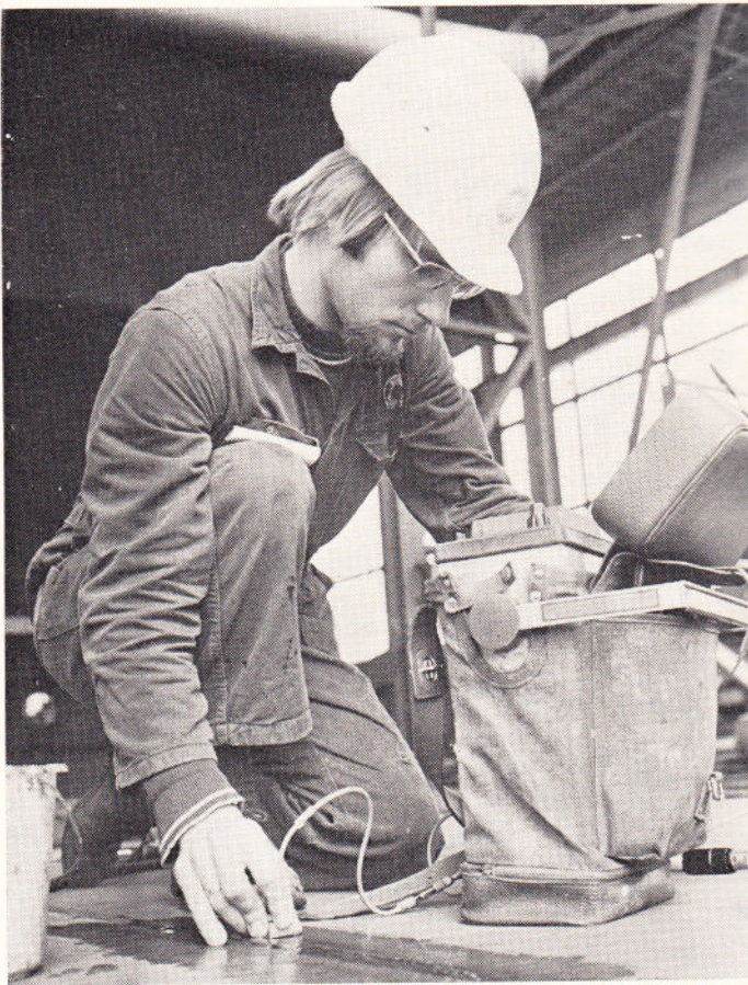
J. Haasdijk, assistent bij lasdeskundige M. Kazen, in actie met het ultrasoonapparaat
