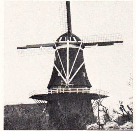
Stellingmolen „Het Hert” te Putten. U kunt hier het rad zien, waarmee de kap van de molen op de wind gezet wordt, het z.g.n. kruien.
