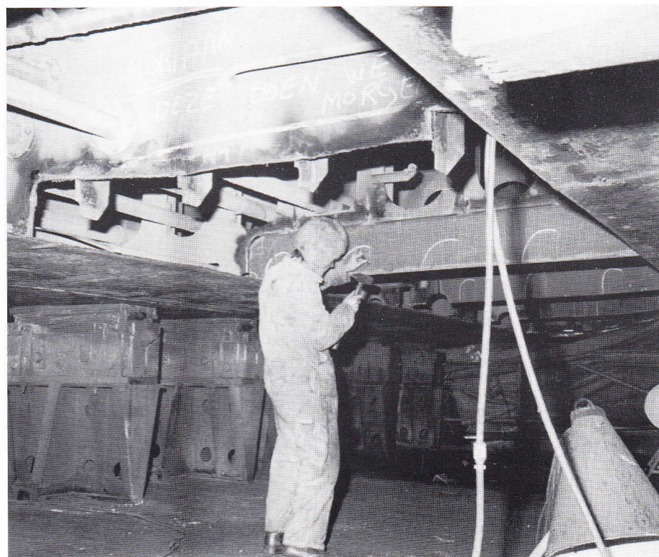
Vlakreparatie van de tanker „Silverfalcon”.
