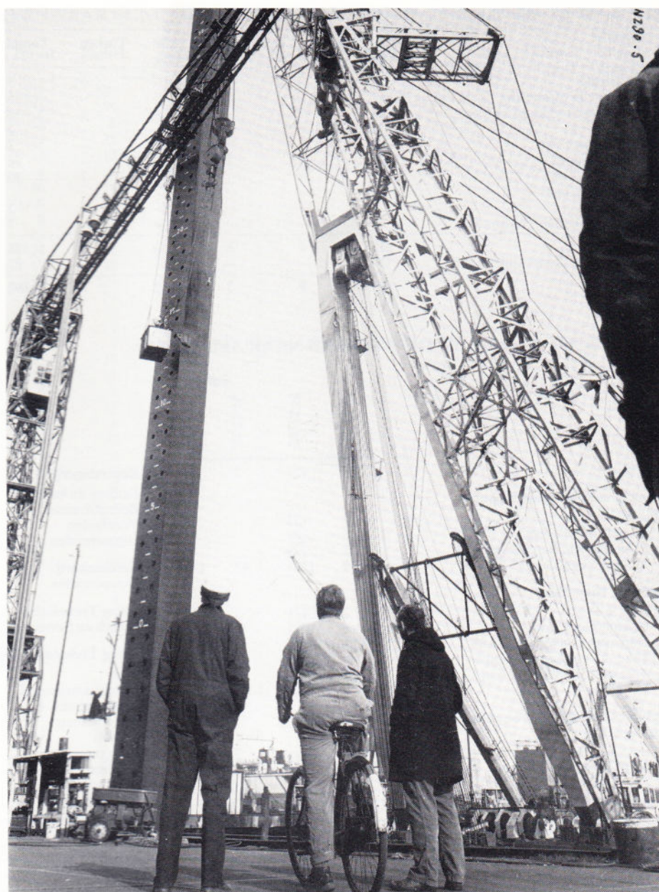
Een potige foto van het plaatsen van één der palen van hefeiland „Dirk”, dat in juni 1978 werd afgeleverd (bouwno. 1064).
